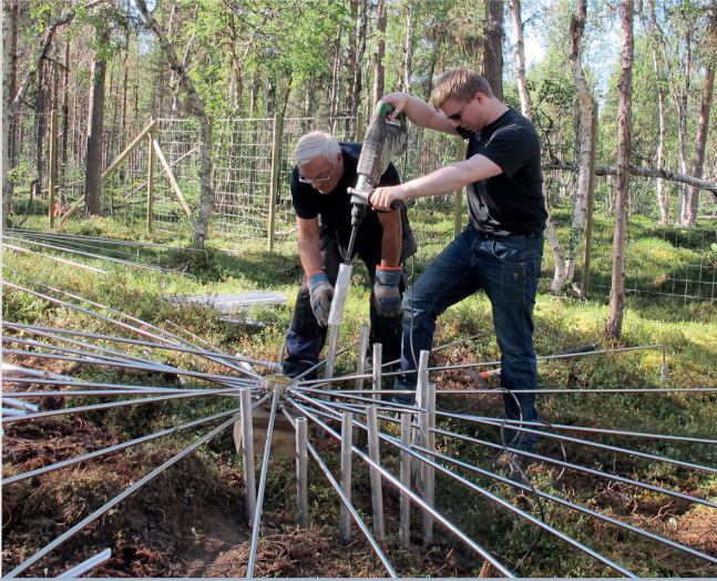
Installation d'un dispositif de tuyaux à la station de surveillance des infrasons IS37, à Bardufoss (Norvège).
