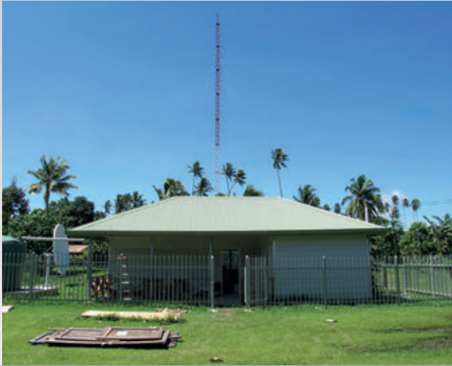
Station auxiliaire de surveillance sismologique AS76, à Keravat (Papouasie Nouvelle-Guinée), qui a été certifiée en 2013.
