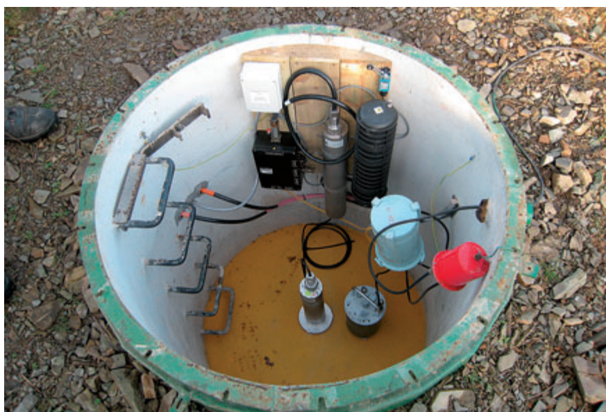
Один из приборных колодезев, составляющих сейсмогруппу вспомогательной сейсмической станции AS104. Эскедимльюр, Соединенное Королевство.
