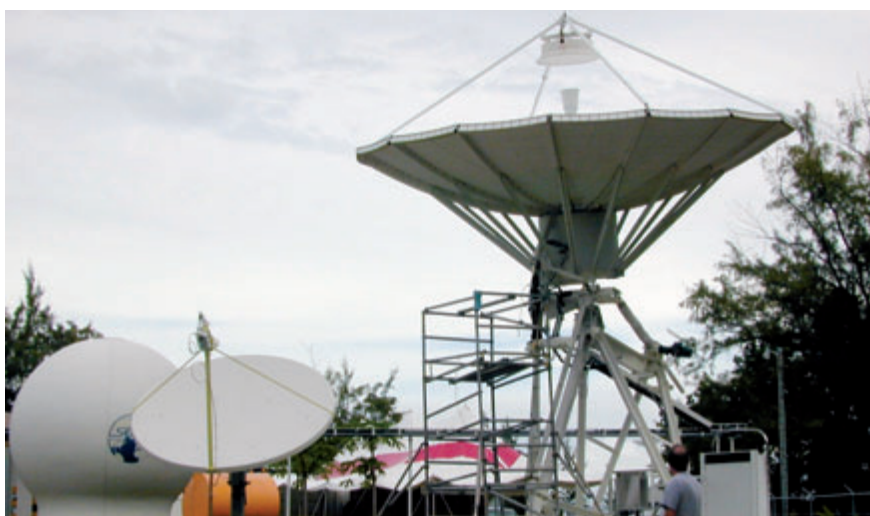
Антенна VSAT (с маленьким отражателем) Инфраструктуры глобальной связи, служащая для передачи данных с гидроакустической станции НАВ, расположенной на о-ве Диего-Гарсия в архипелаге Чагос (Соединенное Королевство), через спутник в Международный центр данных в Вене.
