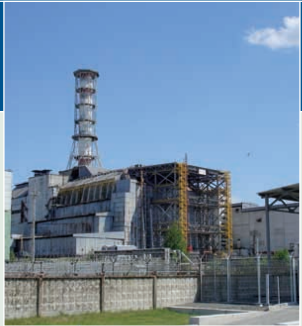
Restos del revestimiento de contención de concreto de una unidad de la central nuclear en la zona de exclusión de Chernobyl.
