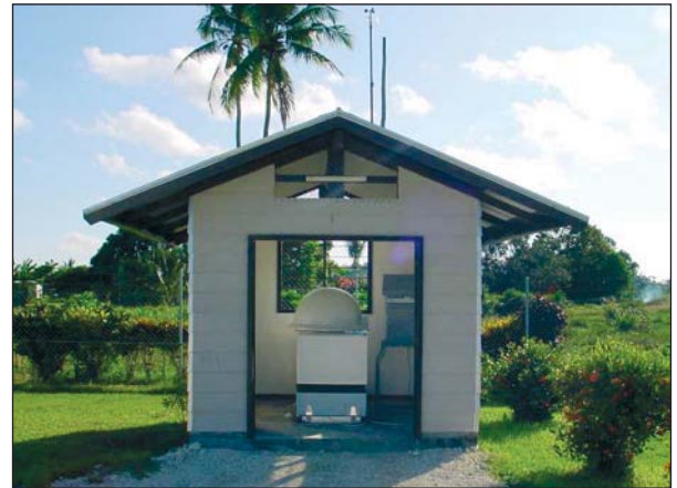
محطة رصد النويدات المشعة RN51 في كافينغ، نيوزيلندا، بابوا غينيا الجديدة، أثناء زيارة اعتماد.
