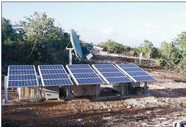
1. Panneaux solaires, blocs-batteries et antenne parabolique de l'élément méridional de la station HA5 (Guadeloupe, France), première station de détection des ondes T à avoir été certifiée (janvier 2002)
