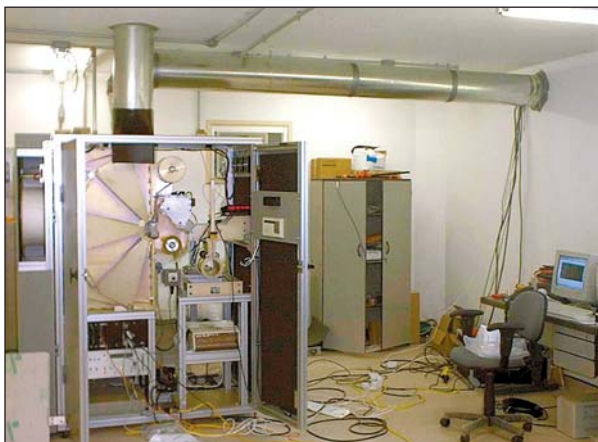
Muestreador de aire automático de macropartículas instalado en la estación de radionúclidos RN11 en Río de Janeiro (Brasil).
