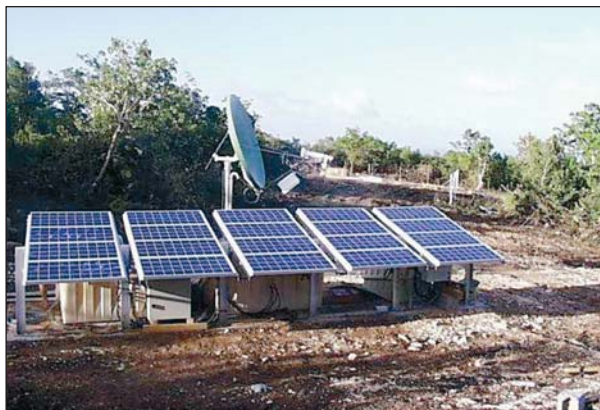
1. Paneles solares, conjuntos de baterías y antenas de satélite en el elemento meridional de la estación HA5 en Guadalupe (Francia), la primera estación hidroacústica de fase T que ha sido homologada (enero de 2002).
