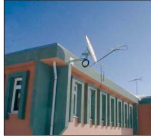
مركز البيانات الوطني والمحطة PS43 في بيلباشي، تركيا.
