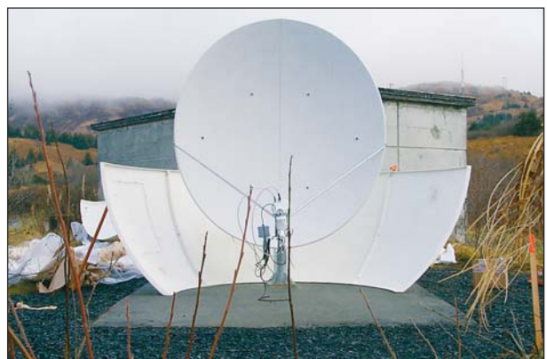
2002 年 12 月，美国，阿拉斯加州，科迪亚克岛，辅助地震台站 AS110，雷达天线屏蔽罩中的甚小孔径终端天线装置。
