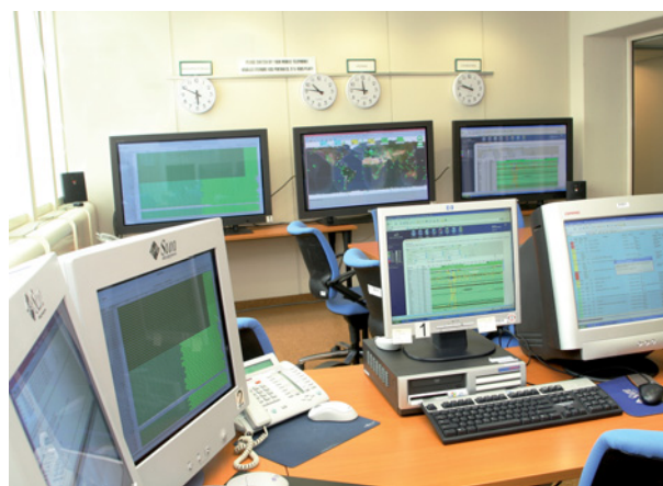
Centro de Operaciones de la STP.
