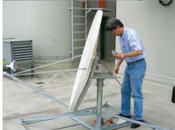
左上图：在水声台站 HA11 安装甚小孔径卫星终端，美国复活岛。
