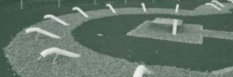
ÉLÉMENT D'UNE STATION INFRASONS, MADAGASCAR
