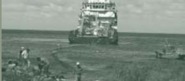
INSTALACIÓN DEL CABLE PARA LA ESTACIÓN HIDROACÚSTICA EN LA ISLA JUAN FERNÁNDEZ
