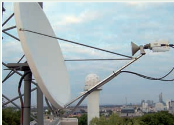
Nouvel émetteur/récepteur de fréquences radio installé sur l'antenne du centre national de données autrichien, à Vienne.
