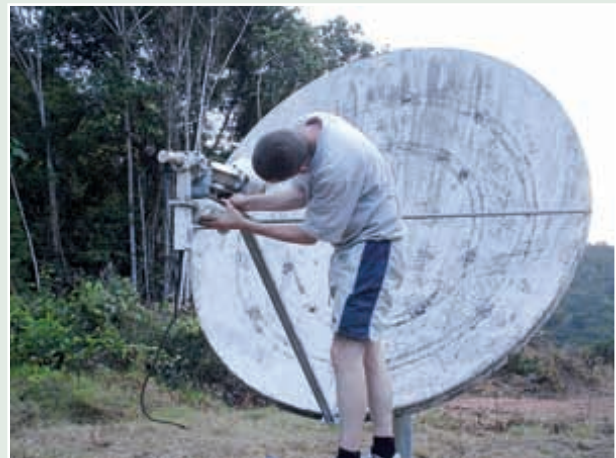
Réparation d'un élément de l'ITM à la station auxiliaire AS10, à Pitinga (Brésil).
