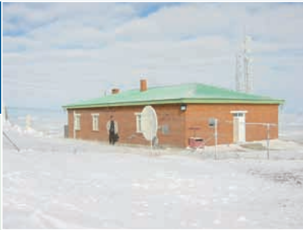
Station sismique primaire PS25, à Songino (Mongolie).
