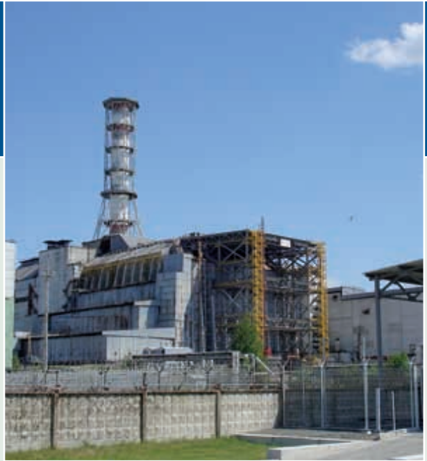
Sarcophage de béton entourant les restes du réacteur dans la zone d'exclusion de la centrale de Tchernobyl.
