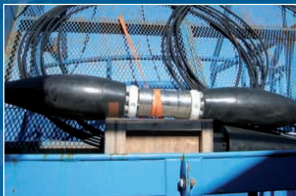
Соединение титановых кабелей.
