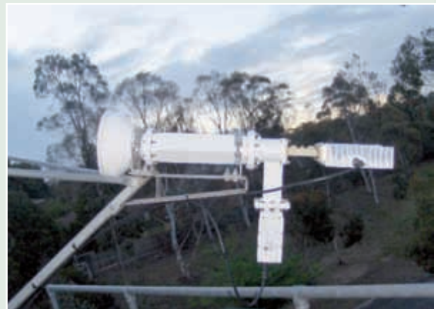
Nuevo cabezal de transmisor-receptor de radiofrecuencia instalado en un emplazamiento de TMPA/VSAT de la IMC que suministra enlaces de comunicaciones a la estación de radionúclidos RN4 y al laboratorio de radionúclidos RL2, situados en Melbourne (Australia).
