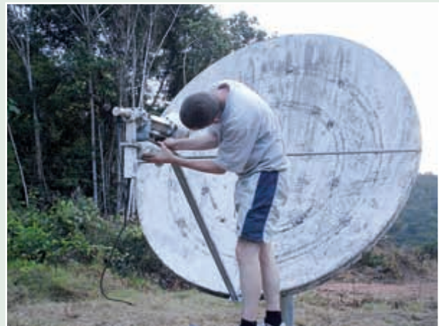
Reparación de dispositivos de la IMC en la estación sísmológica auxiliar AS10, situada en Pitinga (Brasil).
