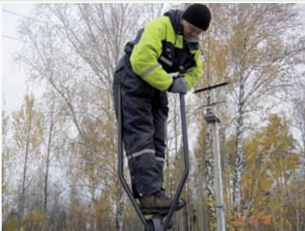
Instalación de una unidad del Sistema mundial de determinación de la posición en la estación sísmológica primaria PS33, situada en Zalesovo (Federación de Rusia).
