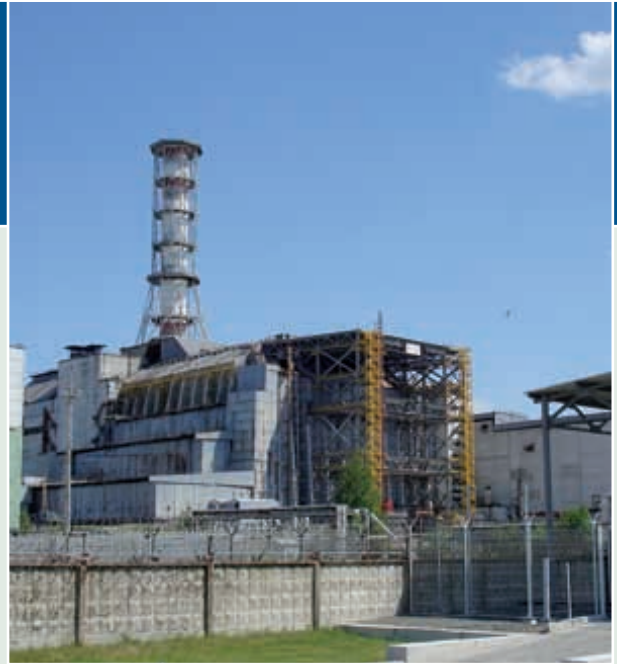
Restos del revestimiento de contención de concreto de una unidad de la central nuclear en la zona de exclusión de Chernobyl.
