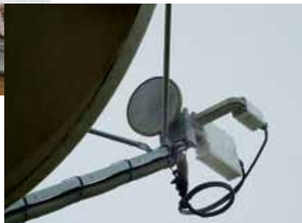
Microstation terrienne de la station PS40, à Sonseca (Espagne): l'absence d'obstacle entre l'antenne et le satellite géosynchrone est la première des conditions indispensables au bon fonctionnement d'une microstation terrienne dans le cadre du réseau mondial de télécommunications.
