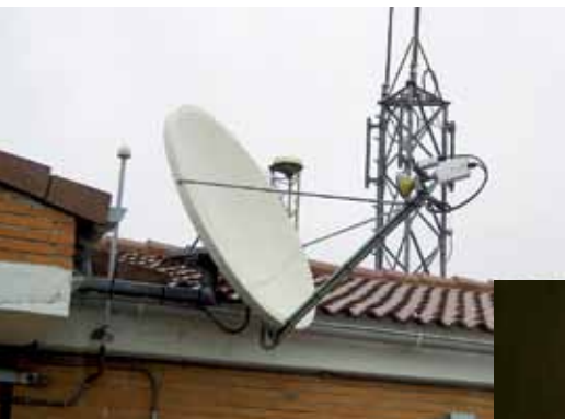
Microstation terrienne de la station PS40, à Sonseca (Espagne): l'absence d'obstacle entre l'antenne et le satellite géosynchrone est la première des conditions indispensables au bon fonctionnement d'une microstation terrienne dans le cadre du réseau mondial de télécommunications.
