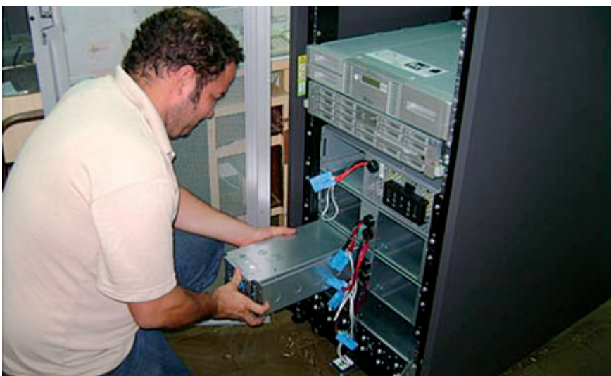
Установка системного оборудования в НЦД Доминиканской Республики, май 2009 года.
