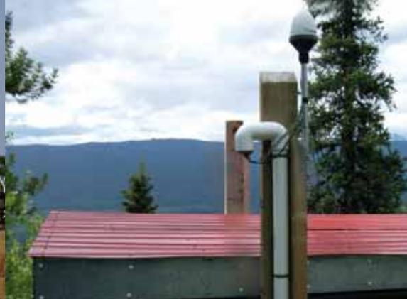
Antenne du Système global de positionnement sur la voûte de la station sismique auxiliaire AS13, Dease Lake, Colombie britannique (Canada).
