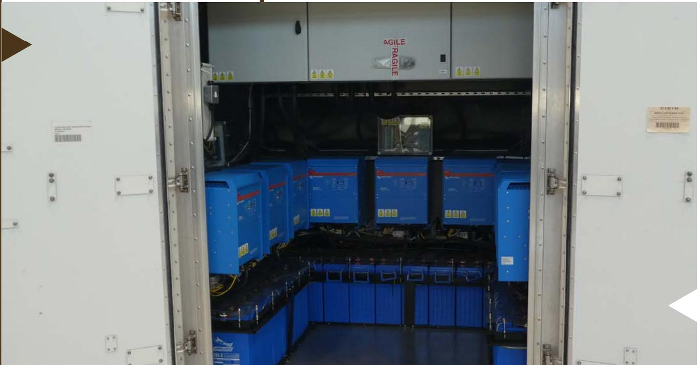
► **Groupe électrogène hybride installé dans une nacelle pour déploiement rapide d'inspections sur place et destiné à compléter l'alimentation électrique avec l'énergie solaire à la base d'opérations.**
