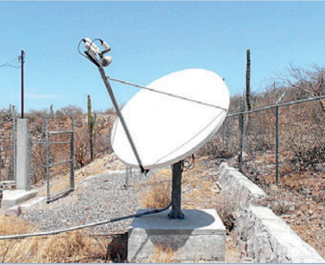
هوائي محطة طرفية واحدة ذات فتحة صغيرة في المحطة السيزمية المساعدة AS65، لا باس، باخا، كاليفورنيا سور، المكسيك، خضع للصيانة في عام ٢٠١٣.
