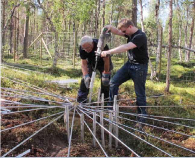
Установка трубчатой антенной решетки на инфразвуковой станции IS37 в Бардифоссе (Норвегия).
