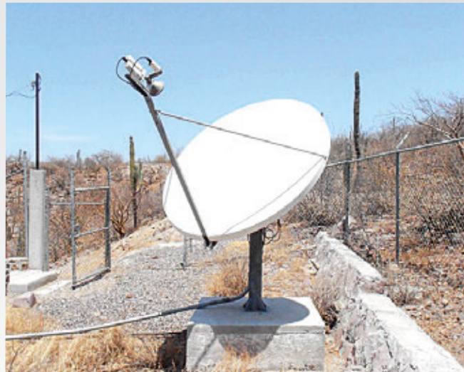
Антенна VSAT вспомогательной сейсмической станции AS65 в Ла-Пасе (штат Южная Нижняя Калифорния, Мексика), на которой в 2013 году было проведено техническое обслуживание.
