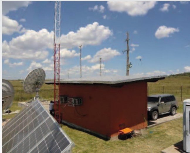
Инфразвуковая станция IS41 в Вилья-Флорида (Парагвай), на которой в 2013 году было проведено техническое обслуживание и замена оборудования.
