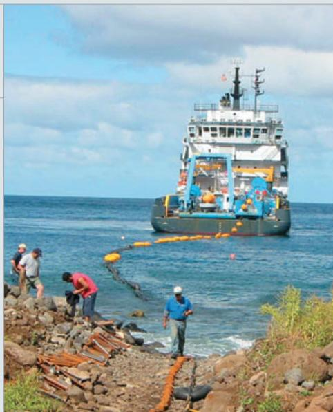
Pose d'un câble immergé près de la station HA3 de surveillance hydroacoustique, île Juan Fernández (Chili). Les flotteurs qui maintiennent le câble à la surface sont retirés par la suite pour permettre au câble de s'immerger.
