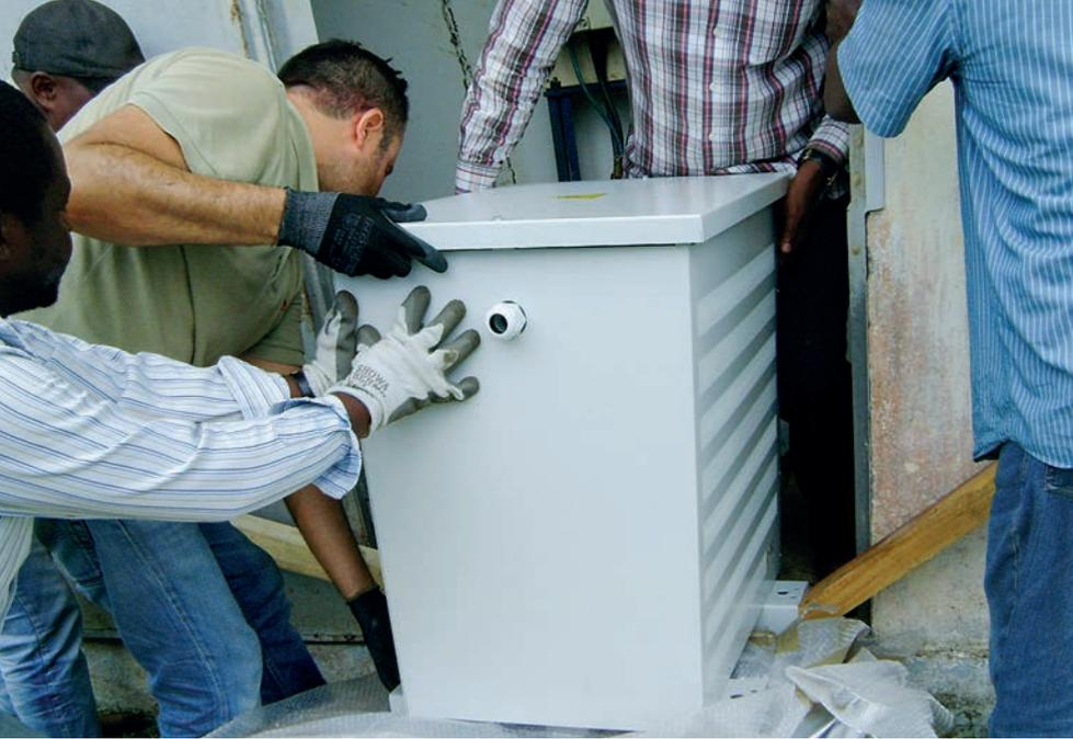
Installation d'un nouveau transformateur à la station de surveillance des radionucléides RN13, à Édéa (Cameroun)
