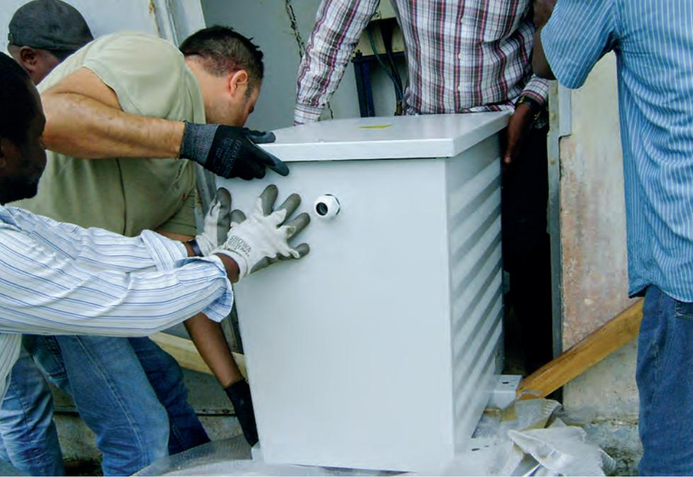
Instalación de un nuevo transformador en la estación de radionúclidos RN13, Edea (Camerún)
