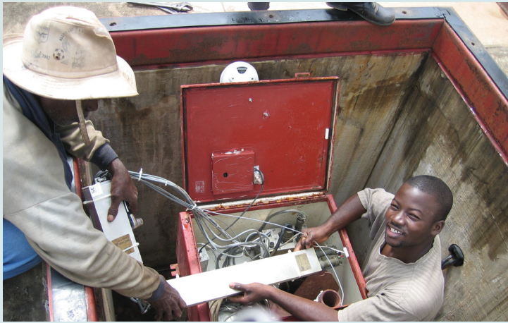
STATION DU RÉSEAU PRIMAIRE DE SURVEILLANCE SISMOLOGIQUE PS15 À DIMBROKO (CÔTE D'IVOIRE)
